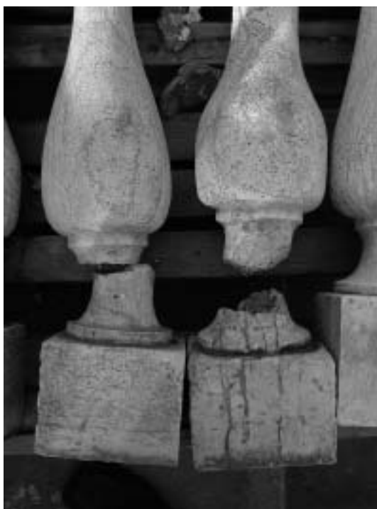
Le fratture e le perdite di materiale delle colonnine (a sinistra) e il montaggio delle parti restaurate (a destra)
