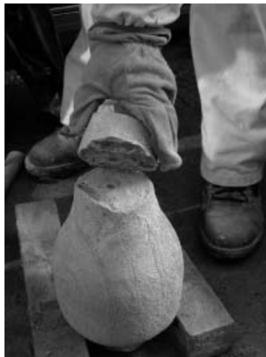
Le fratture e le perdite di materiale delle colonnine (a sinistra) e il montaggio delle parti restaurate (a destra)
