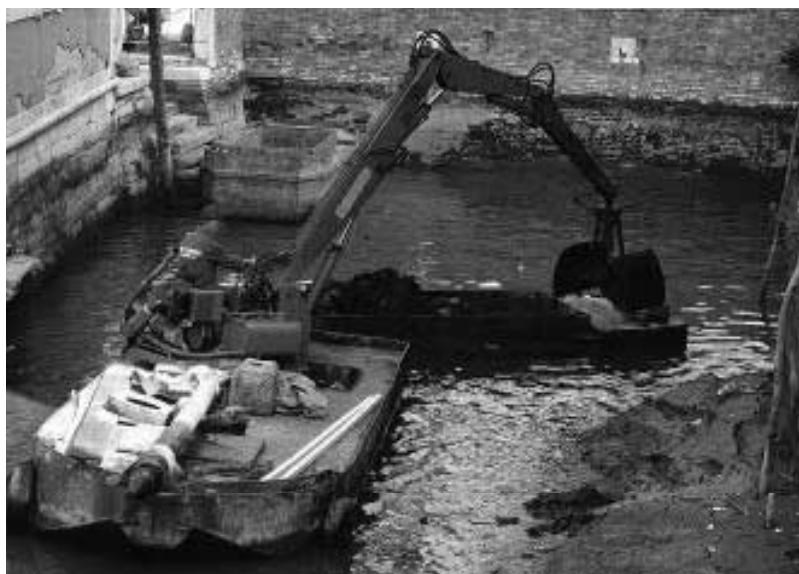
Scavo in presenza d'acqua in Rio dei Frari, maggio 1998
