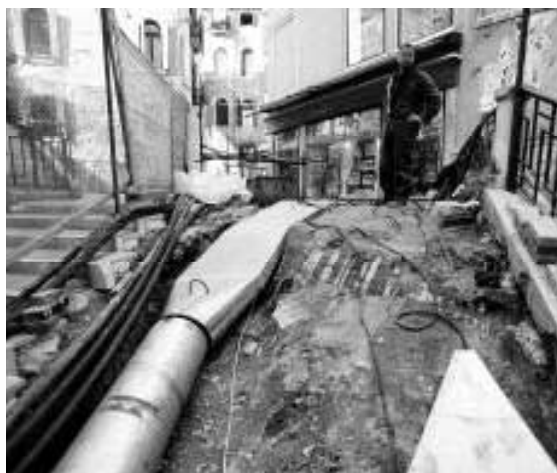
Manutenzione del ponte di S. Giovanni Grisostomo, aprile 1999
