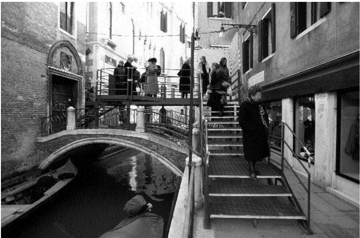
Passerella metallica sul ponte di S. Tomà durante i lavori di manutenzione
