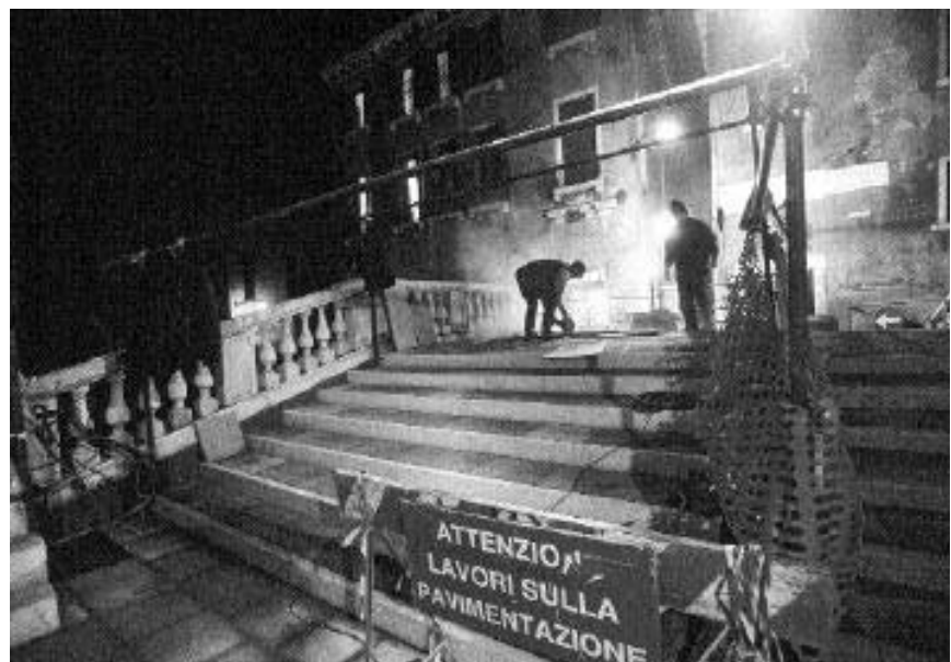
Ponte di San Polo. Lavoro notturno
