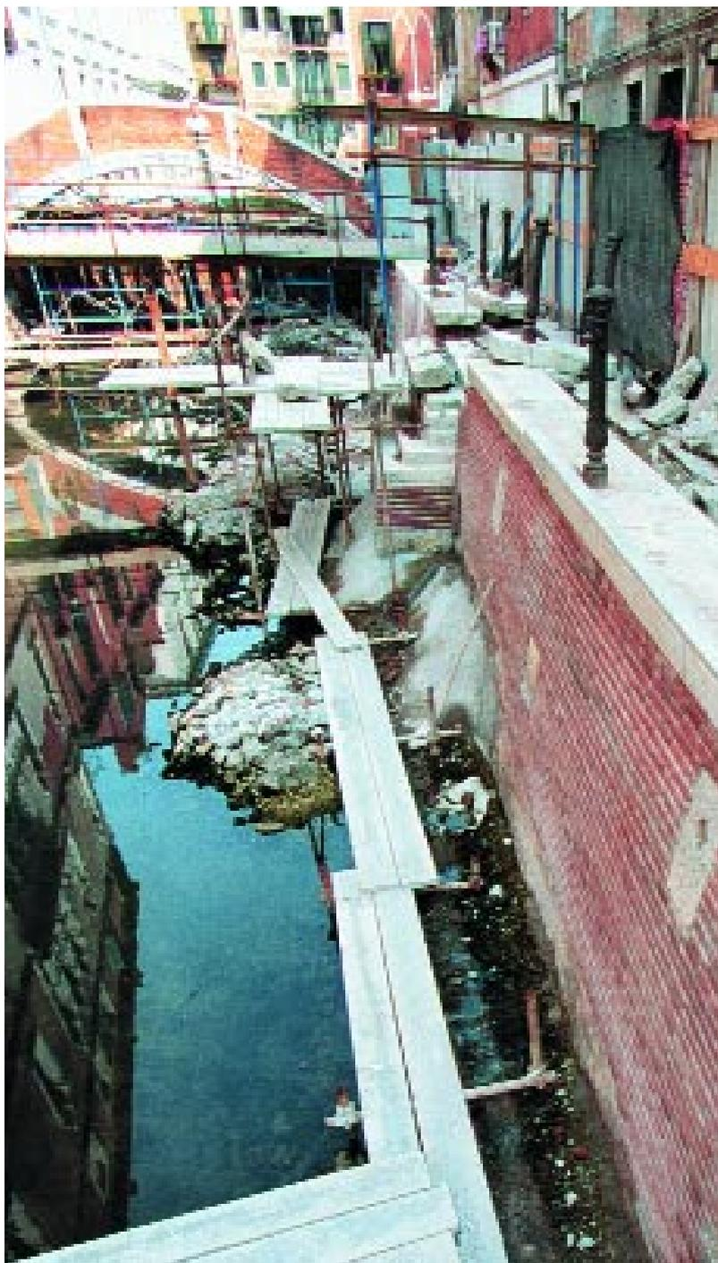
*Rio di San Severo, opere di restauro sul muro di sponda e rialzo della pavimentazione, giugno 1999*
