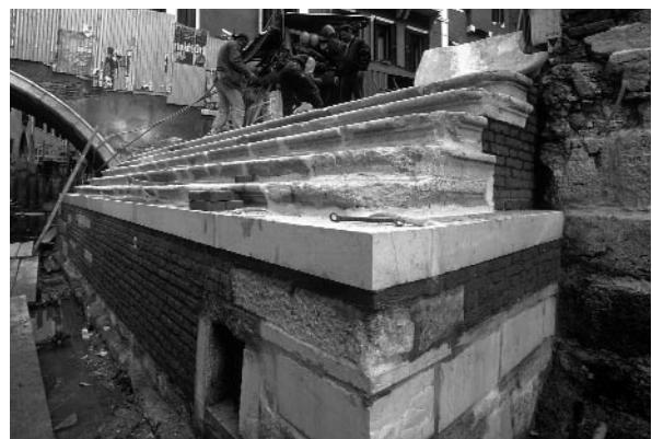
lavori in corso di ultimazione
