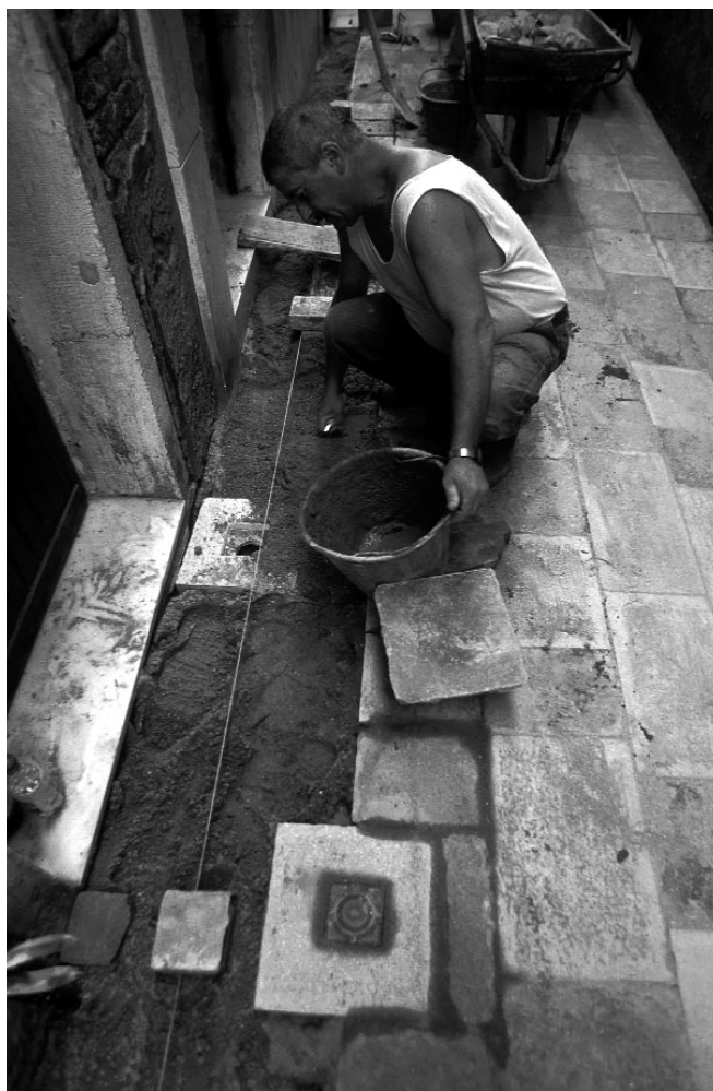
Posa dei masegni in calle del Forno
