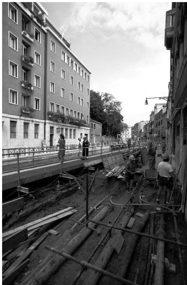
Lavori su fondamenta dei Tolentini
