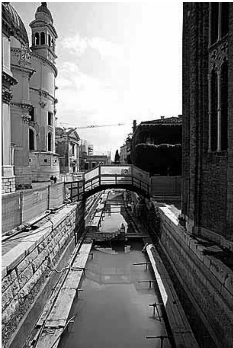
Cantiere per il restauro delle sponde di rio della Salute.
