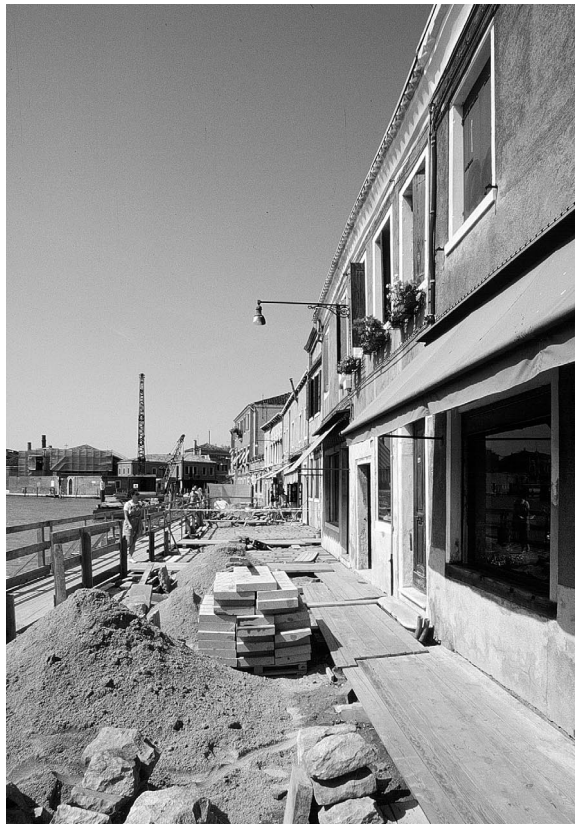
Murano: lavori sulla Fondamenta Navagero
