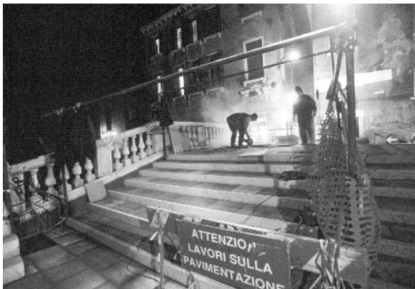
Lavoro notturno sul ponte di San Polo
