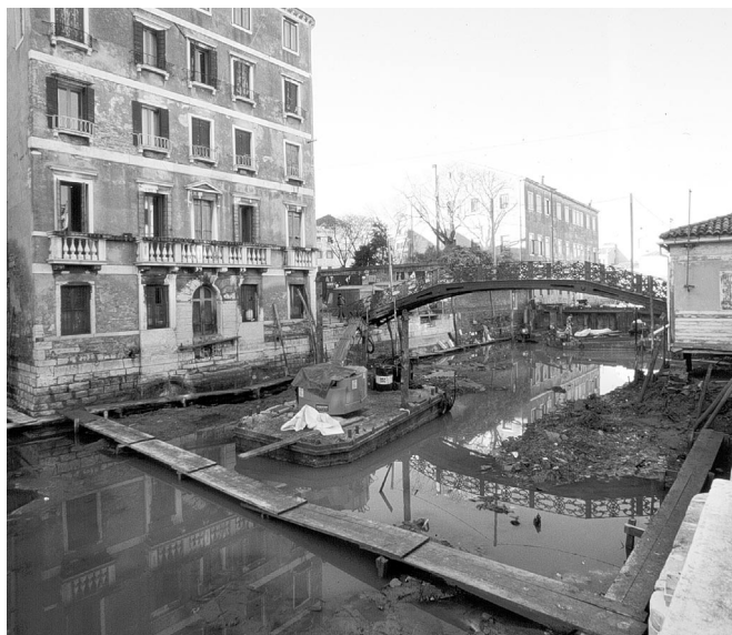
Attività di scavo nell'insula del Ghetto
