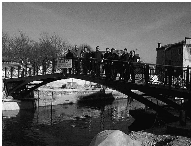
Lo staff dei tecnici sul nuovo ponte appena posato
