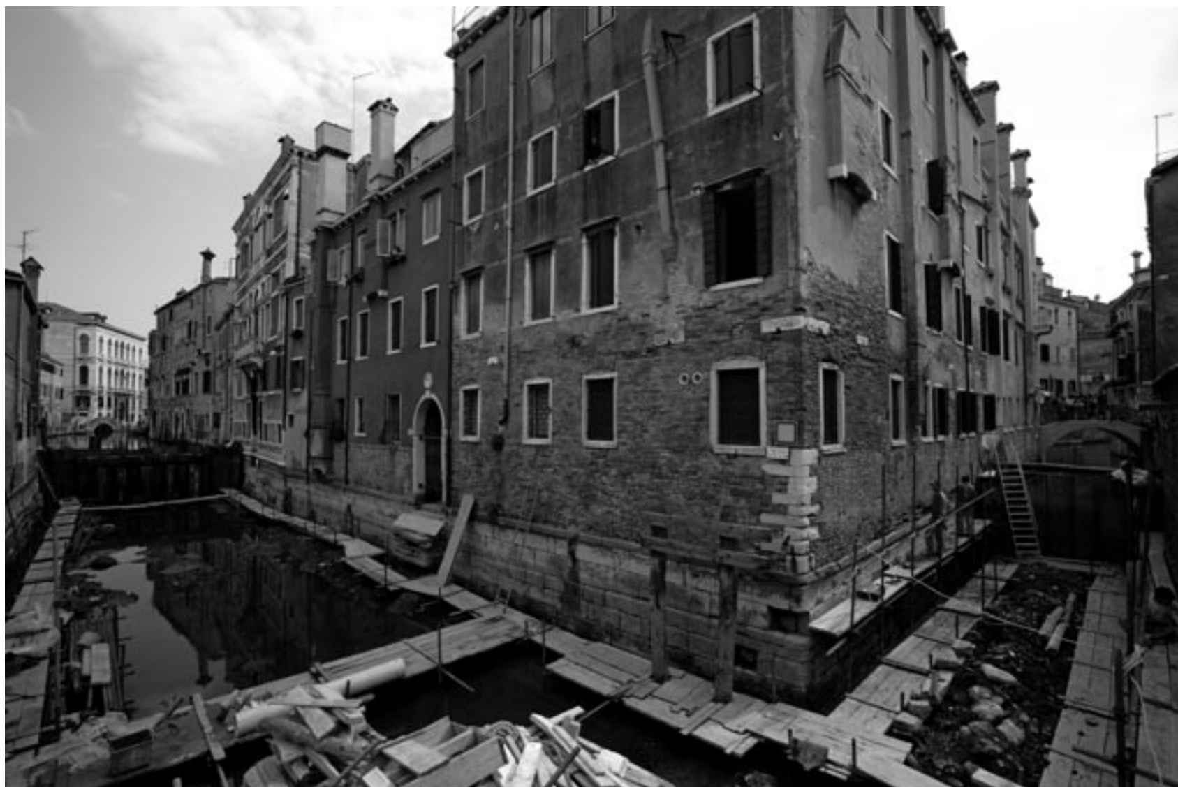
Il cantiere all'incrocio tra rio di San Marcuola e rio dei Servi.
