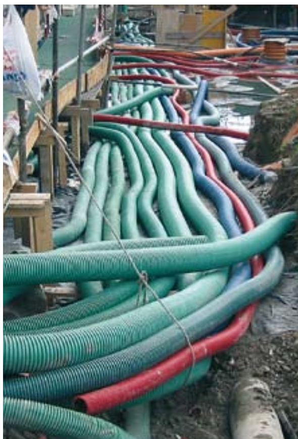
Pellestrina, realizzazione dei sottoservizi in uno dei lotti secondari.
