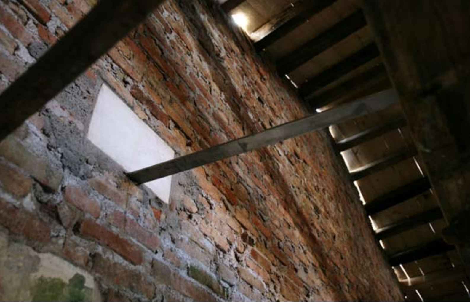
Chiesa di Sant'Anna, messa in sicurezza della copertura.
