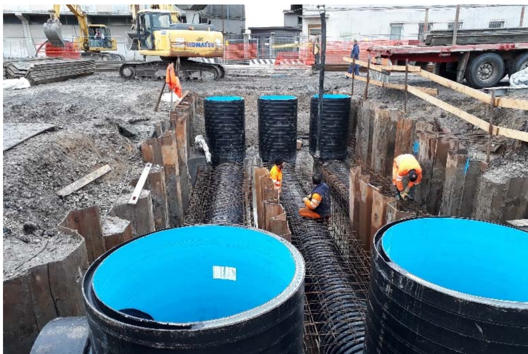
CANTIERE IN VIA RIGHI VIA DEI PETROLI
