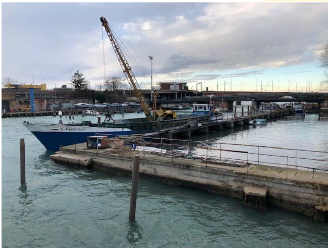
SCAVO DAVANTI ALLA EX PISCINA RARI NANTES
