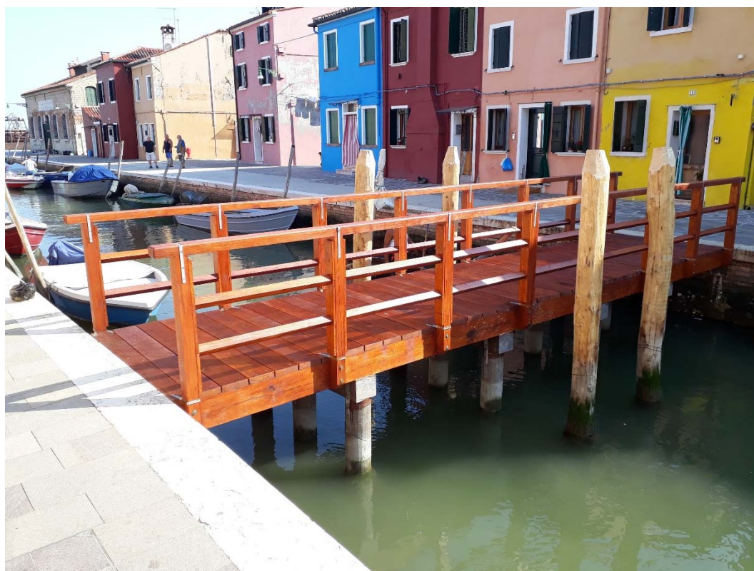
LA PASSERELLA A RASO REALIZZATA A BURANO
