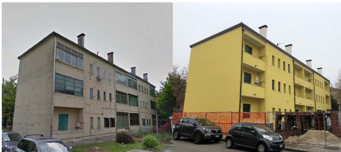
VIA BECCARIA A MARGHERA, PRIMA E DOPO I LAVORI
