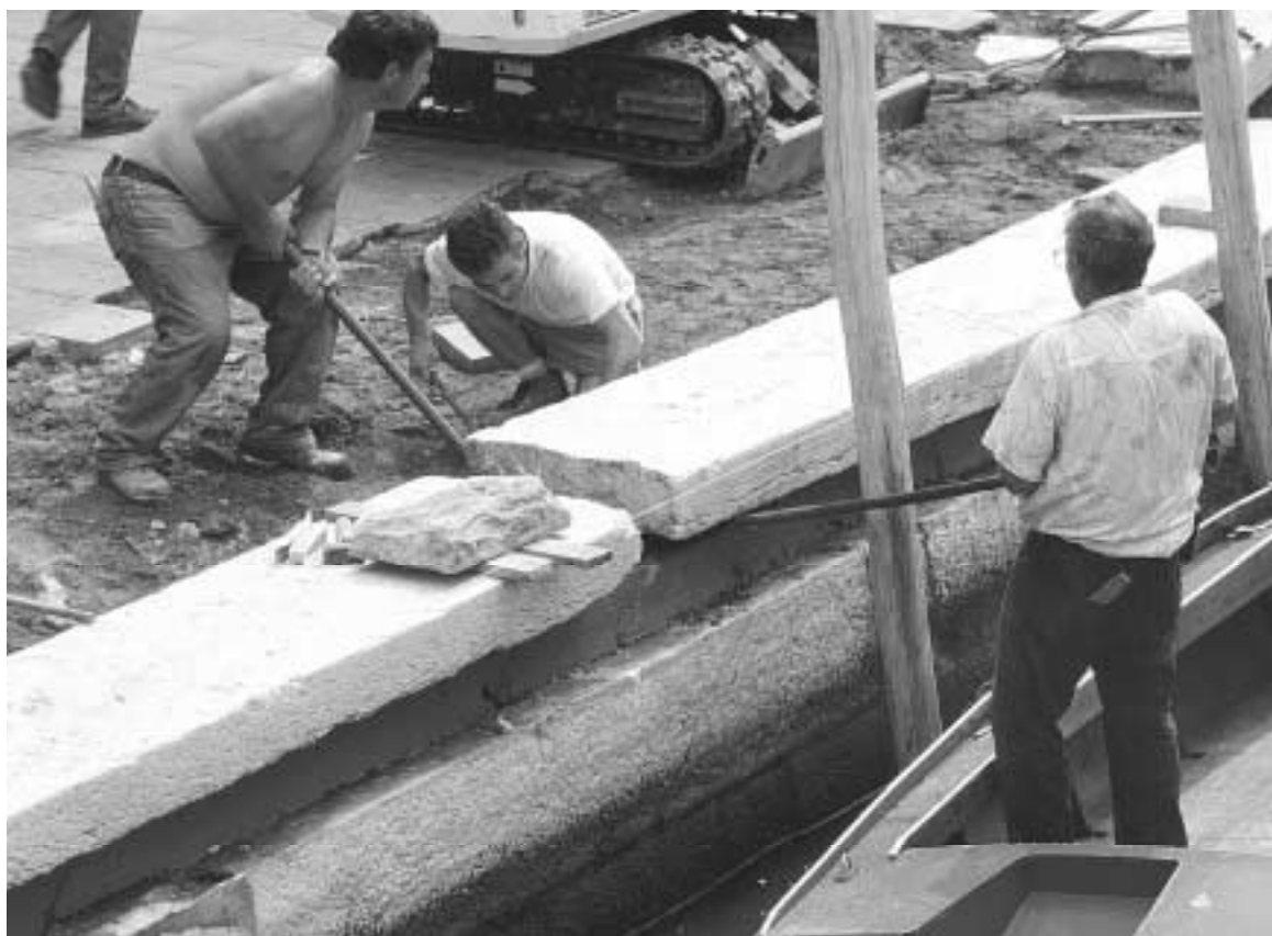
Operazioni di rialzo della pavimentazione in Fondamenta degli Ormesini
