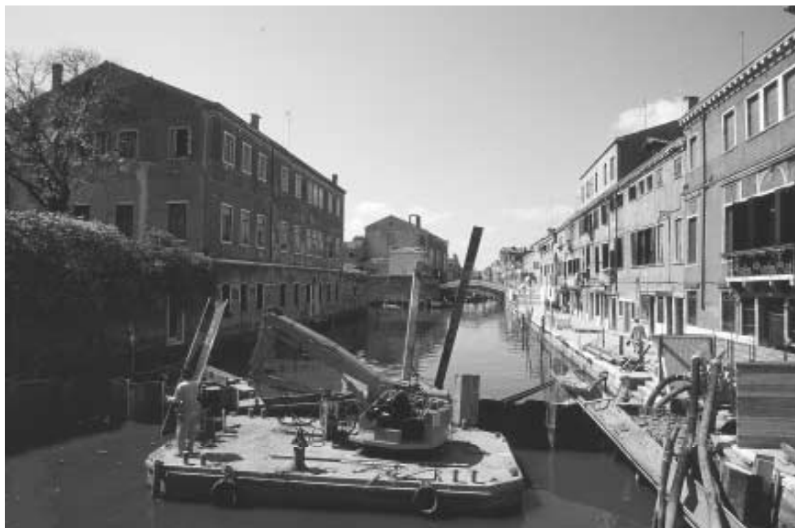
Cantiere del Ghetto: infissione delle palancole sul Rio della Misericordia
