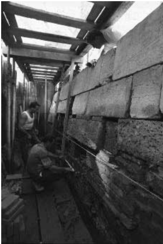
Risanamento della sponda di Fondamenta dei Tolentini, 1998
