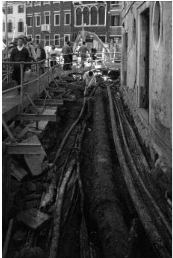
Razionalizzazione dei sottoservizi in Fondamenta dei Tolentini, 1998
