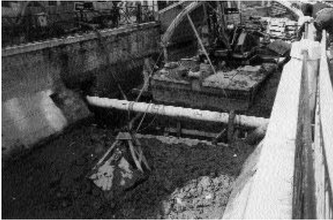
Rio Marin. Varo del nuovo sifone in acciaio dell'Aspiv
