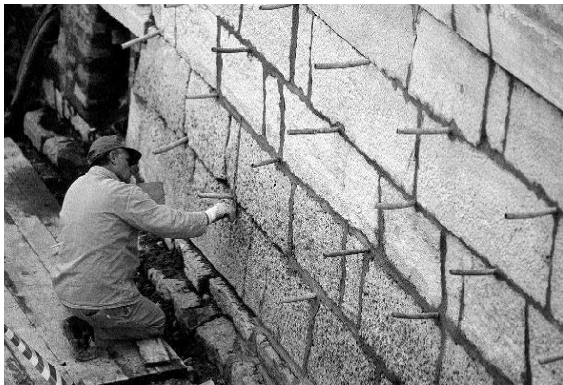
Rio di San Stin: preparazione del paramento murario per le fasi di iniezione, mediante l'inserimento di tubetti in PVC
