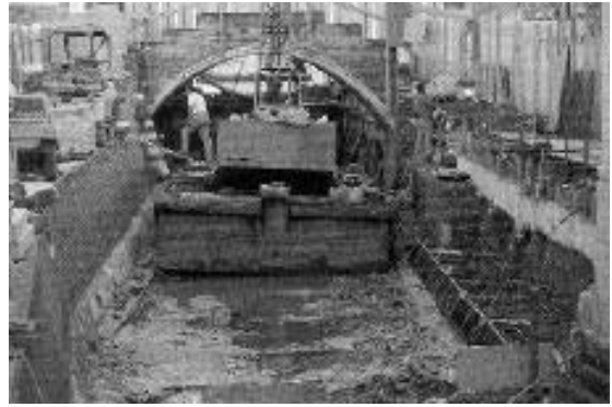
Rio de la Frescada. Rifacimento delle banchine
