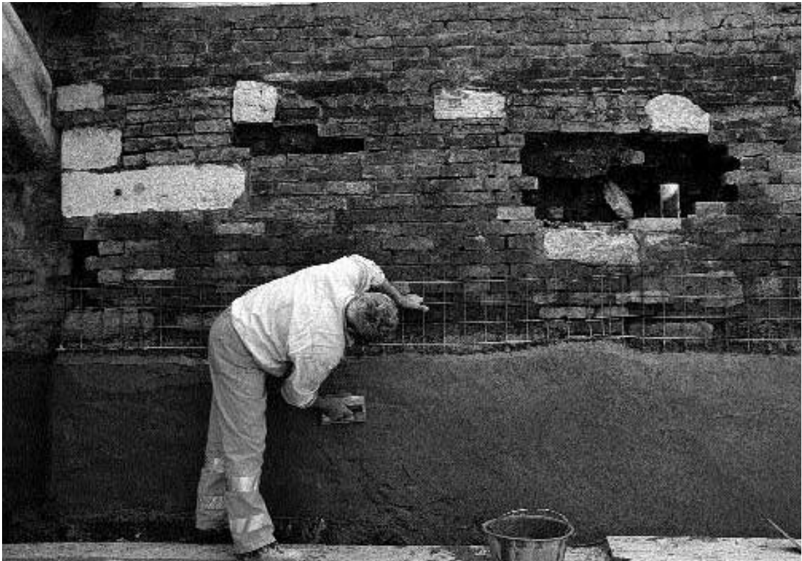
Rio di San Tomà: intonacatura di protezione, con malta fibro-armata, sulla fascia di paramento murario più esposta ai vortici delle eliche. Si notino nella parte superiore le evidenti manifestazioni di degrado del paramento
