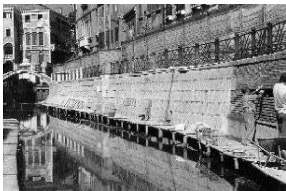
Rio Marin: iniezioni e ricuciture murarie sulla sponda
