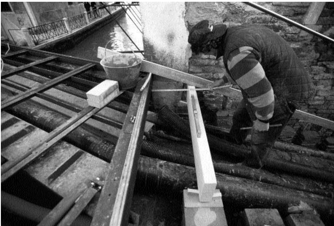
Ponte della Bergama: ricollocazione dei sottoservizi
