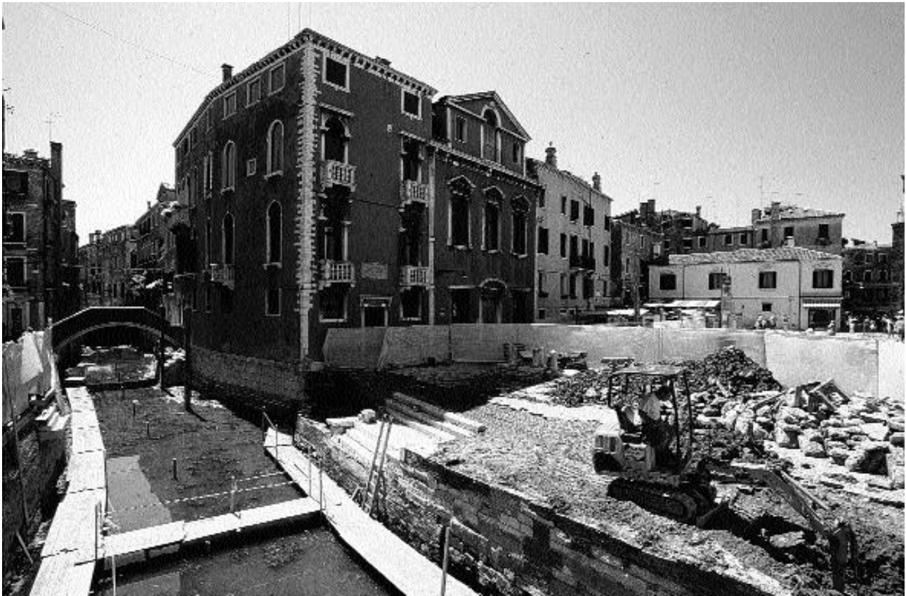
Cantiere in Campo dei Frari
