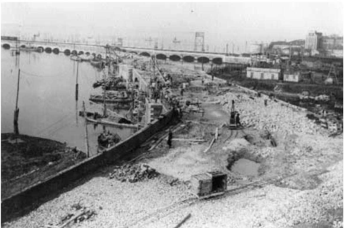
Due immagini della costruzione del ponte translagunare, 1933
