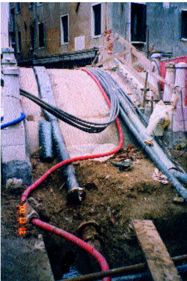
Posizionamento dei sottoservizi sull'estradosso di ponte Sant'Antonin, 1999
