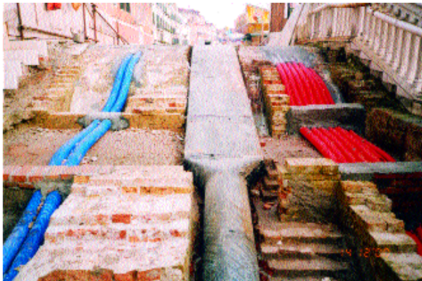
Ponte del Sepolcro, sostituzione della vecchia tubatura in ghisa (sopra) con una nuova sagomata in acciaio (sotto)
