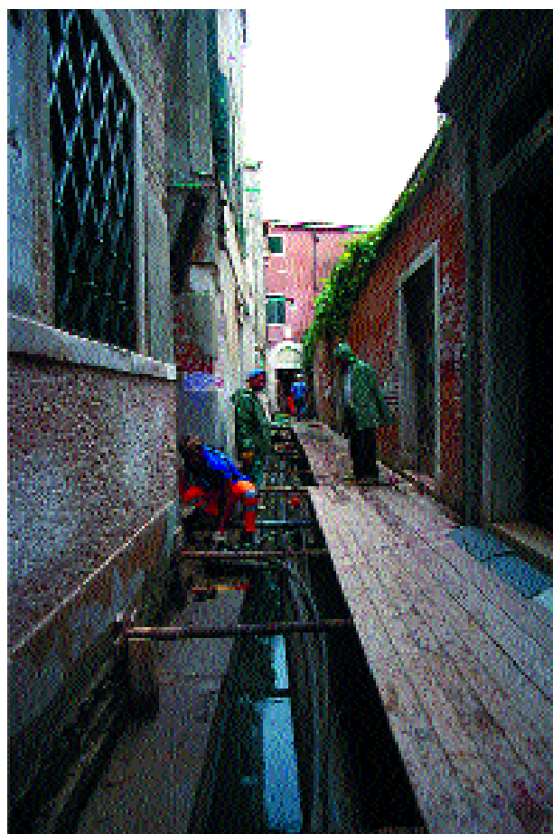
Lavori sulla fognatura di calle Zorzi a S. Giovanni in Bragora
