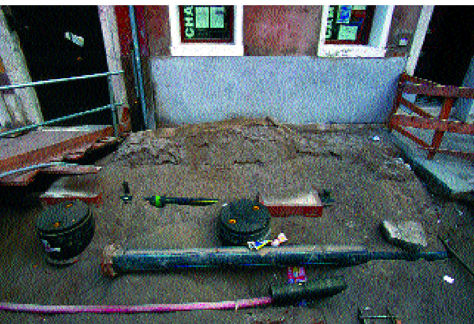
Cantiere in fondamenta dei Tolentini: nuovi pozzetti di ispezione, 2000
