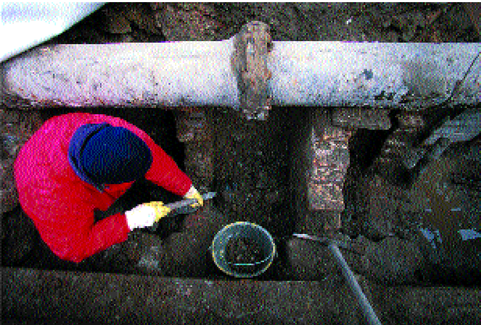
Ripristino di uno scarico in fondamenta Santa Giustina, 2000
