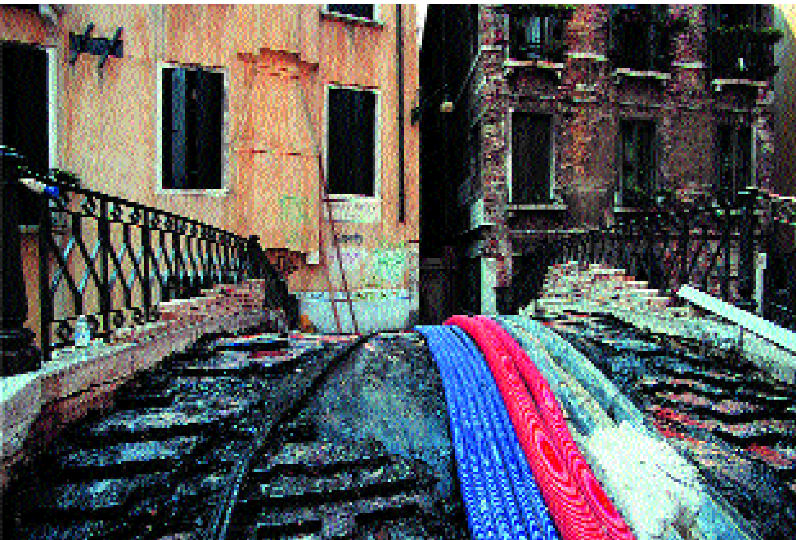
Rinnovo dei sottoservizi sul ponte de la Fava, 1999
