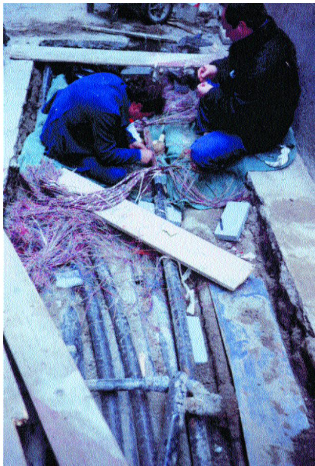
Operazione di giunzione e smistamento dei cavi
