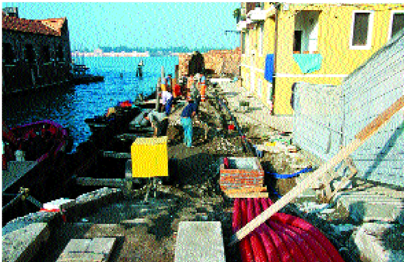
Lavori in fondamenta di Santa Giustina, 2000
