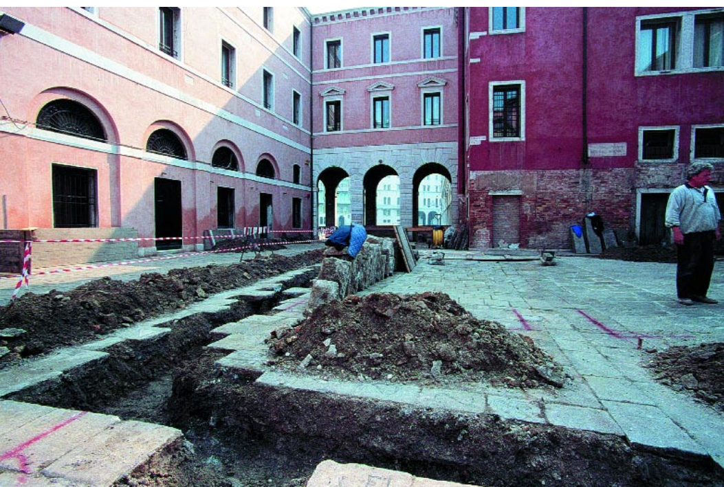
Lavori preparatori per lo spostamento provvisorio del mercato ortofrutticolo in campo Cesare Battisti (detto anche della Cordaria o della Bella Vienna), marzo 1999
