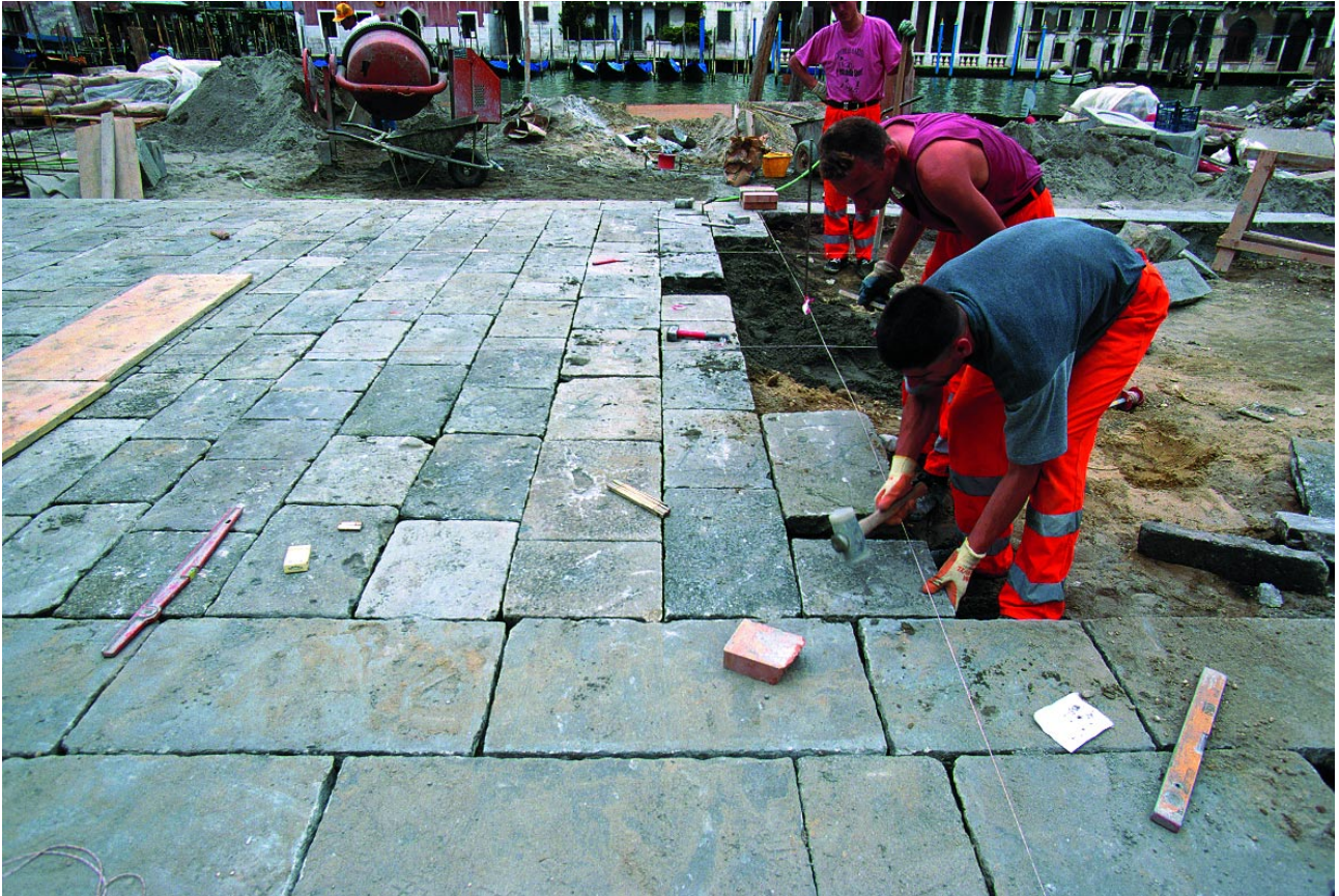
Posa della pavimentazione in campo della Pescaria, aprile 2000
