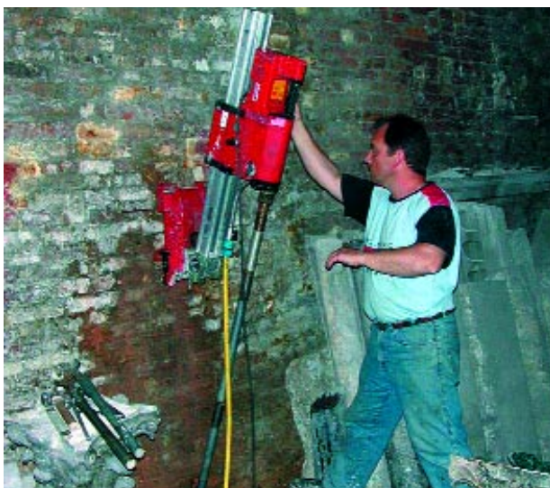
Fig. 5 - Carotaggio meccanico nelle murature e rilievo con sonda televisiva
