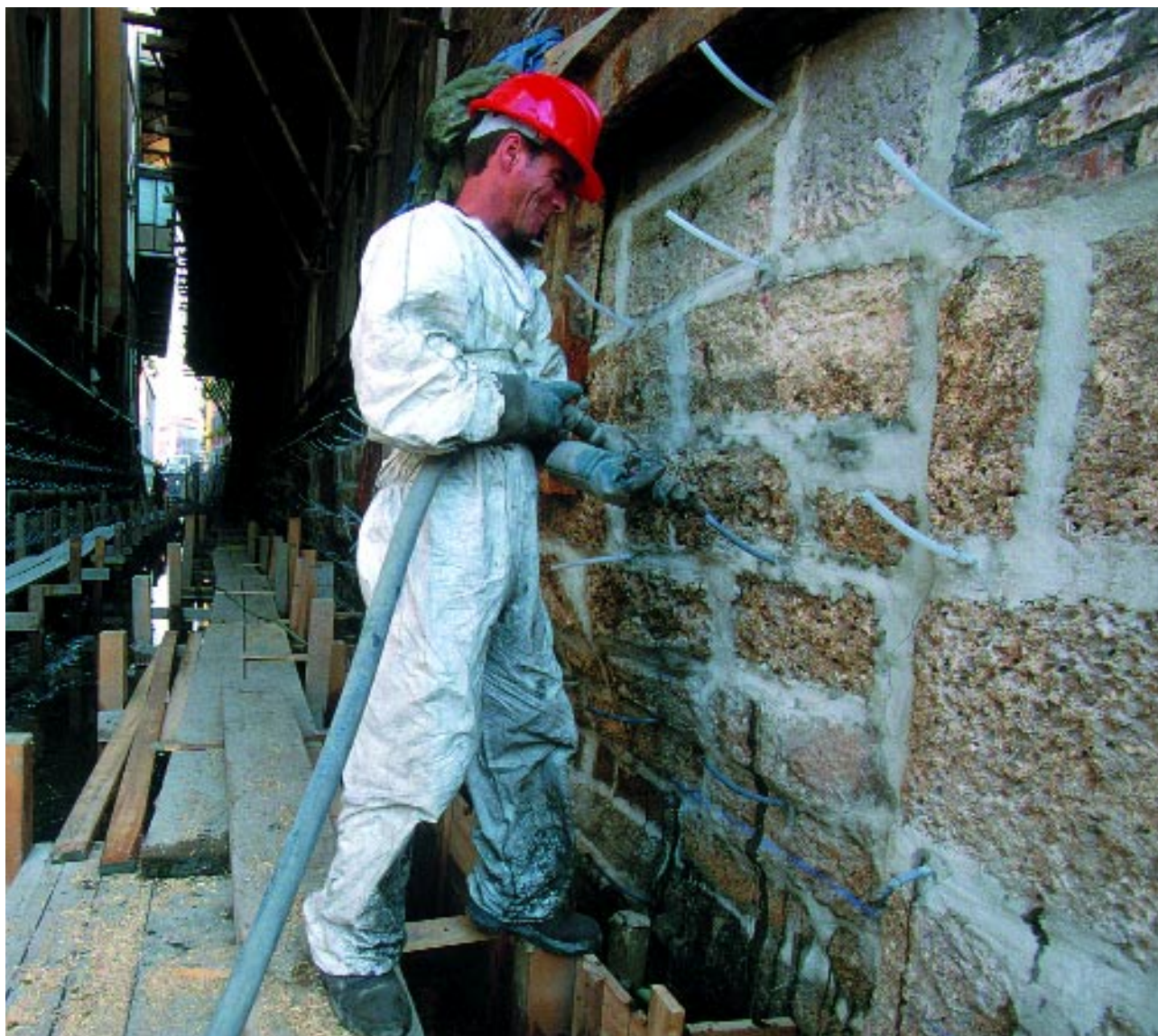
L'iniezione della miscela. Rio dell'Orso, insula di Santo Stefano, ottobre 2000
