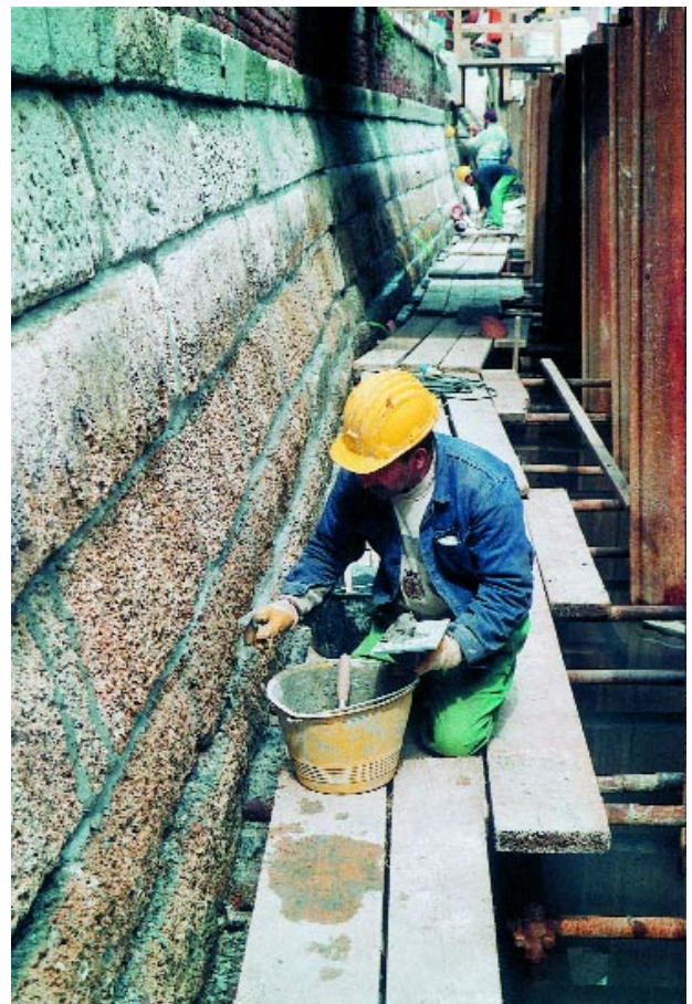
Fig. 13 - Ristilatura dei giunti in rio della Pietà
