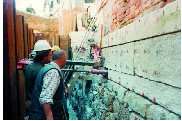
Fig. 11 e 12 - In rio della Pietà l'ispezione all'interno della muratura di sponda è avvenuta in momenti successivi: lo smontaggio di un bolognino in pietra d'Istria, il prelievo di micro campioni di materiale, il carotaggio della muratura retrostante, l'ispezione interna attraverso l'endoscopio
