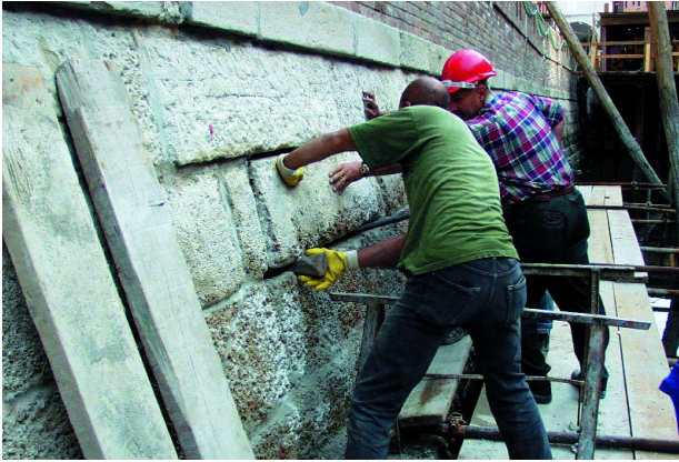
Fig. 11 e 12 - In rio della Pietà l'ispezione all'interno della muratura di sponda è avvenuta in momenti successivi: lo smontaggio di un bolognino in pietra d'Istria, il prelievo di micro campioni di materiale, il carotaggio della muratura retrostante, l'ispezione interna attraverso l'endoscopio
