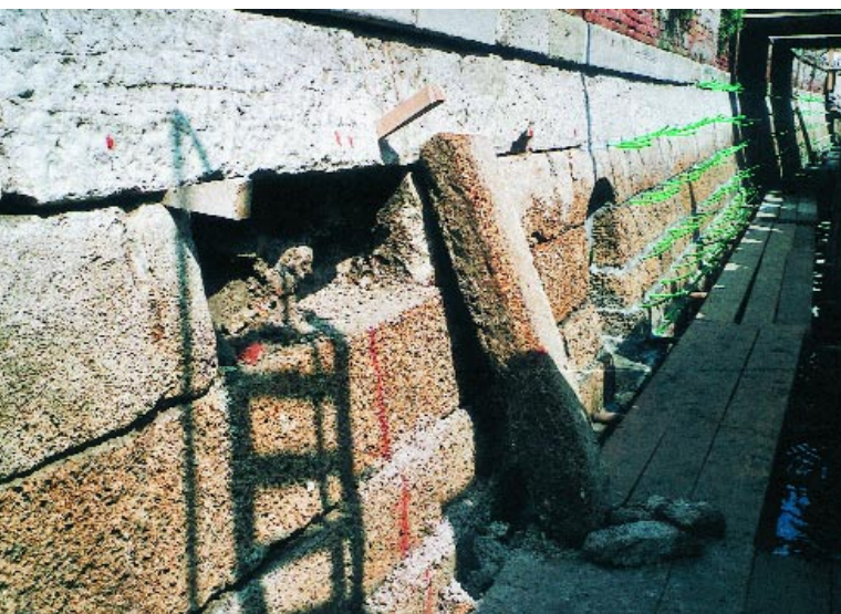
Fig. 15 - Il muro di sponda in rio della Pietà durante la fase dell'iniezione
