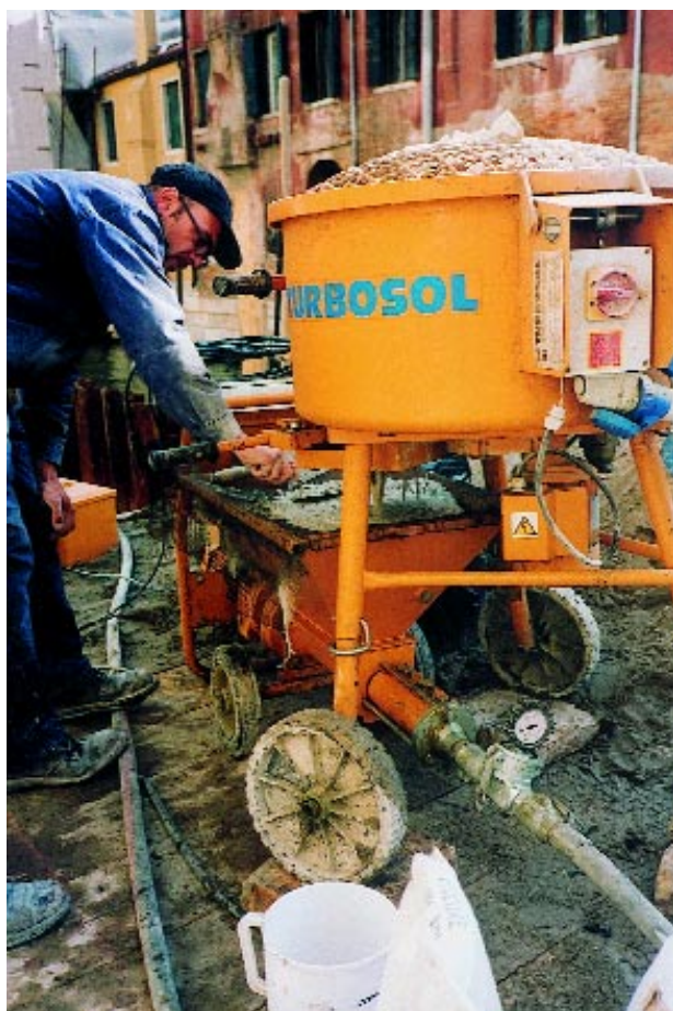
Fig. 16 - Il controllo sulla pompa per l'iniezione
