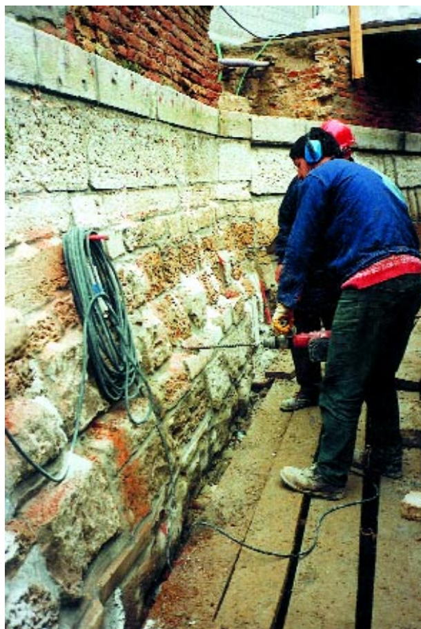
Fig. 14 - Realizzazione dei fori per le iniezioni in rio della Pietà
