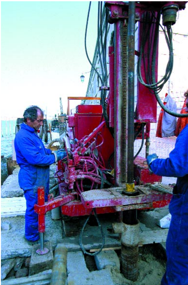
Fig. 9 - Esecuzione di un carotaggio su muro di sponda
