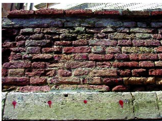
Sopra, il prospetto del muro originario e la posizione dei punti di riferimento per le prove soniche. Nelle immagini sono rappresentati alcuni particolari del paramento murario all'interno e all'esterno della trinca
