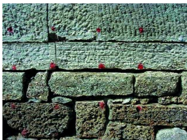
Sopra, il prospetto del muro originario e la posizione dei punti di riferimento per le prove soniche. Nelle immagini sono rappresentati alcuni particolari del paramento murario all'interno e all'esterno della trinca
