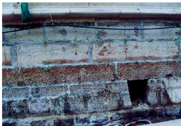
Vista del muro di fondazione di palazzo Zorzi alla conclusione della fase di consolidamento. Si notano la ristilatura dei giunti e ancora qualche cannula utilizzata per le iniezioni consolidanti
