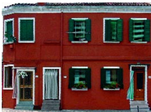
Fig. 4 - Esempio di soglie rialzate per difendersi dall'acqua alta sull'Isola della Giudecca
