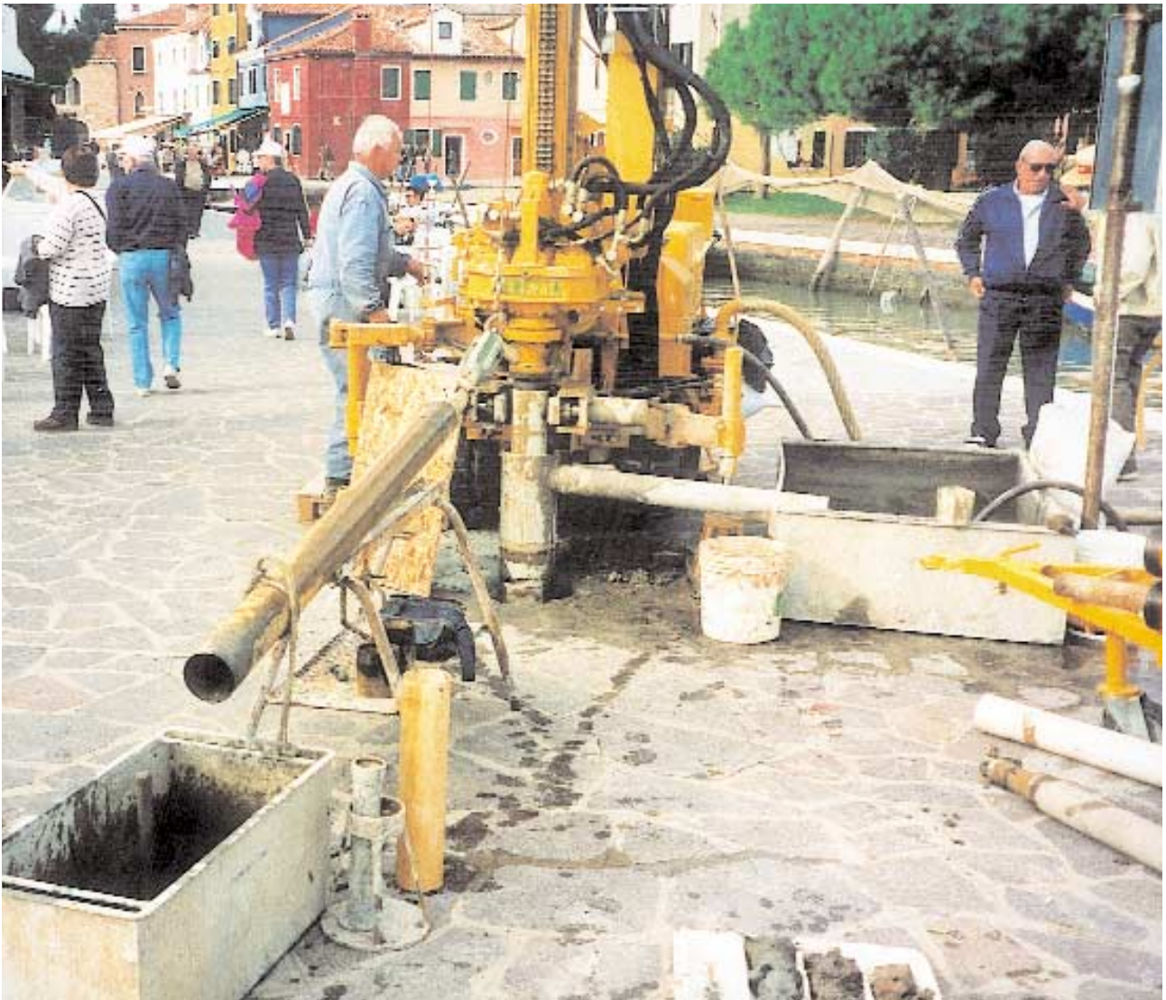
Esecuzione di sondaggio sulla riva di rio Mandracchio
