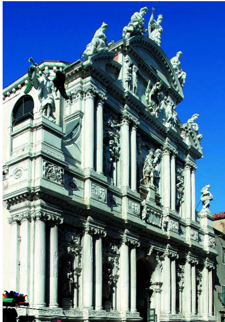
Chiesa di Santa Maria del Giglio, facciata, 1989-96
