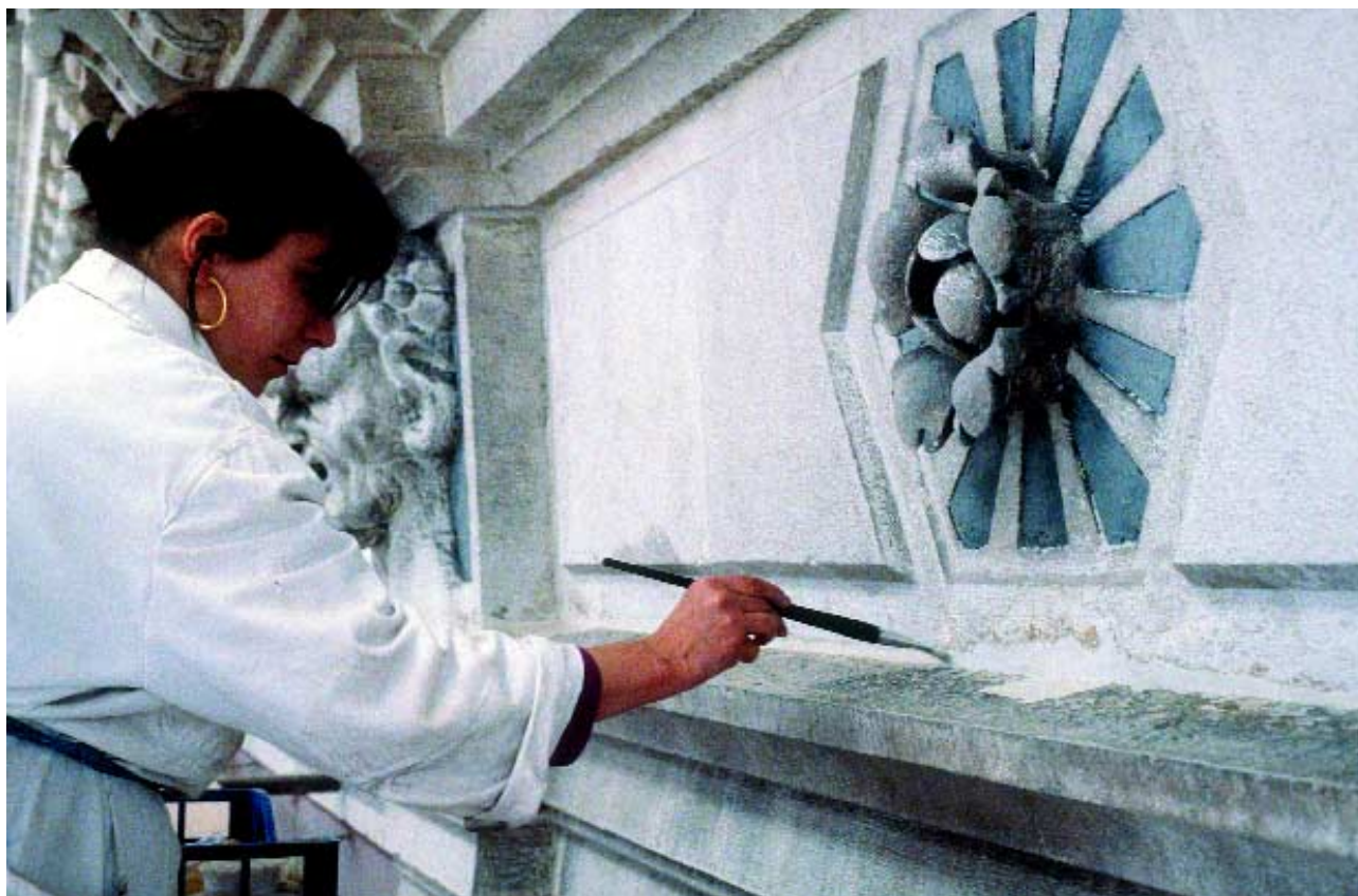
Interventi di restauro
