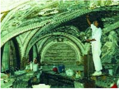
Basilica dei Santi Giovanni e Paolo, restauro della soffitta della sagrestia, 1992-94
