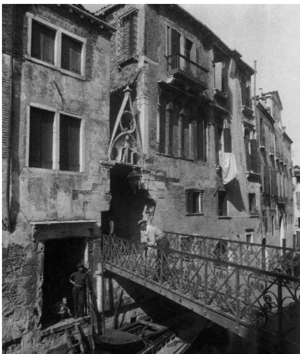
La passerella ottocentesca in ferro localizzata al posto dell'antico ponte del Paradiso in cotto e pietra d'Istria, ora ripristinato con gli stessi materiali
