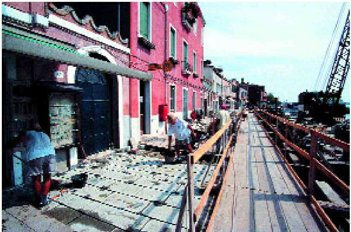
Fondamenta Navagero, rialzo e posa della pavimentazione
