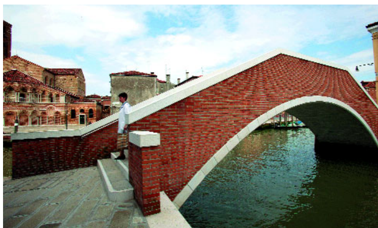
Ponte San Martino, lavori in corso e ultimati
