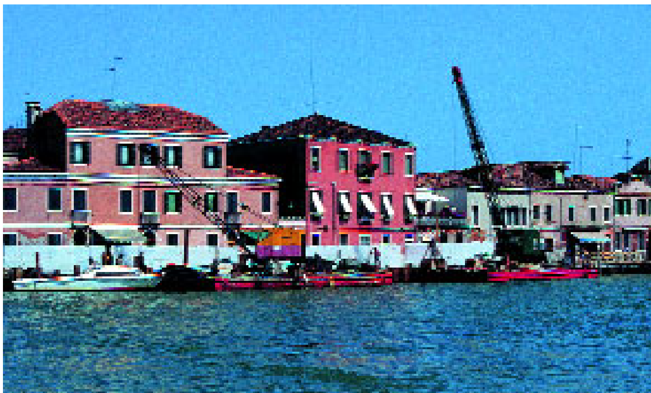
Fondamenta Navagero durante i lavori
