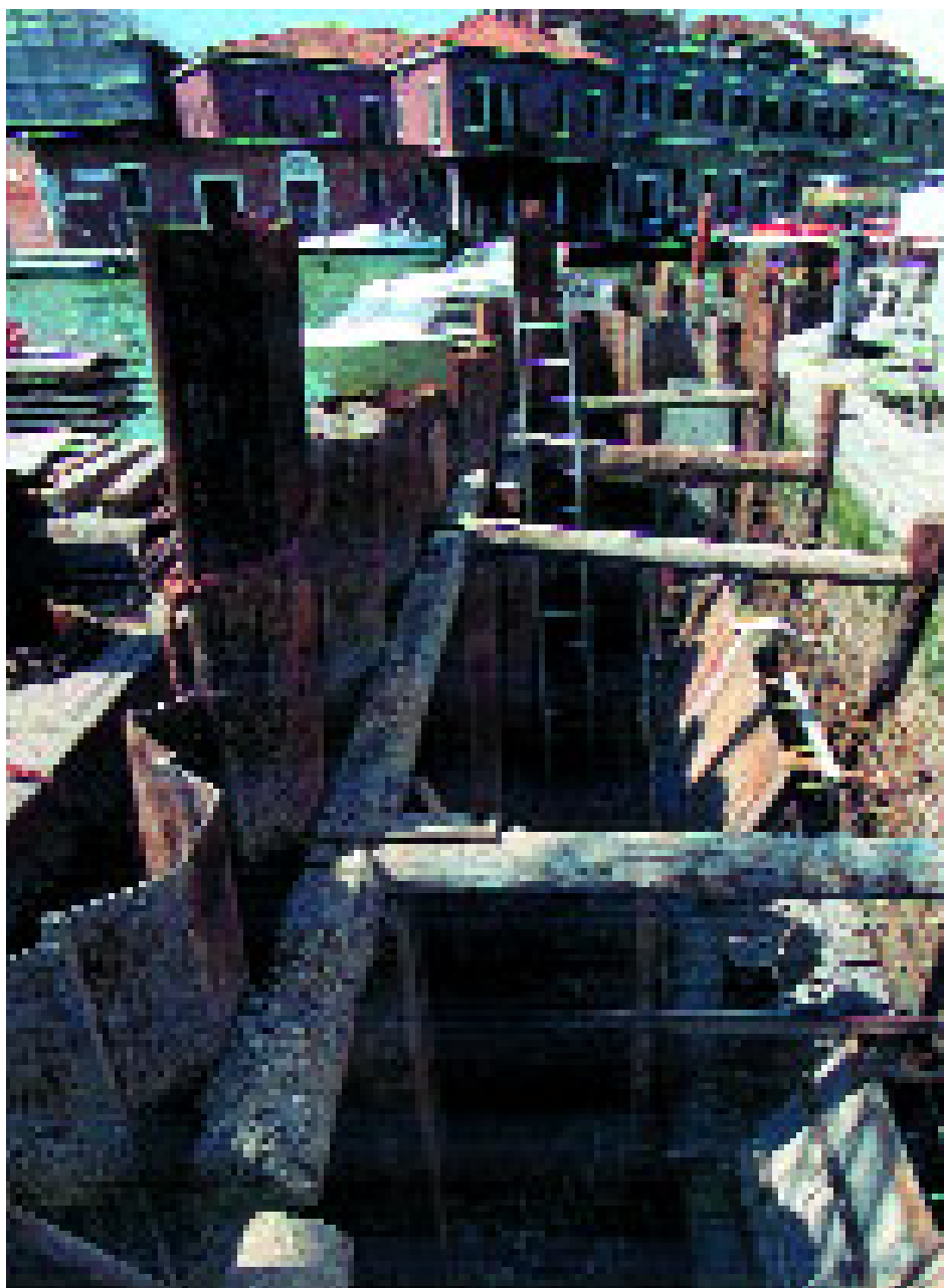
Fondamenta Navagero, la costruzione del nuovo muro di sponda in adiacenza all'antico
