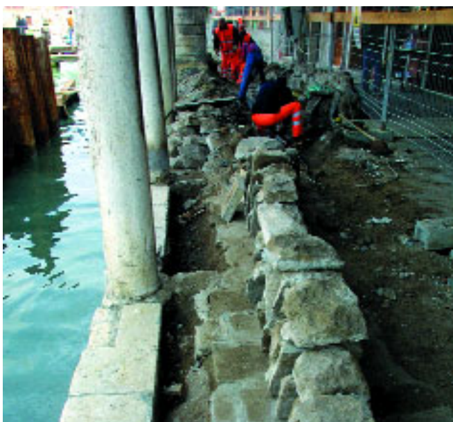
Fondamenta Ca' Navagero, l'intervento sui sottoservizi
