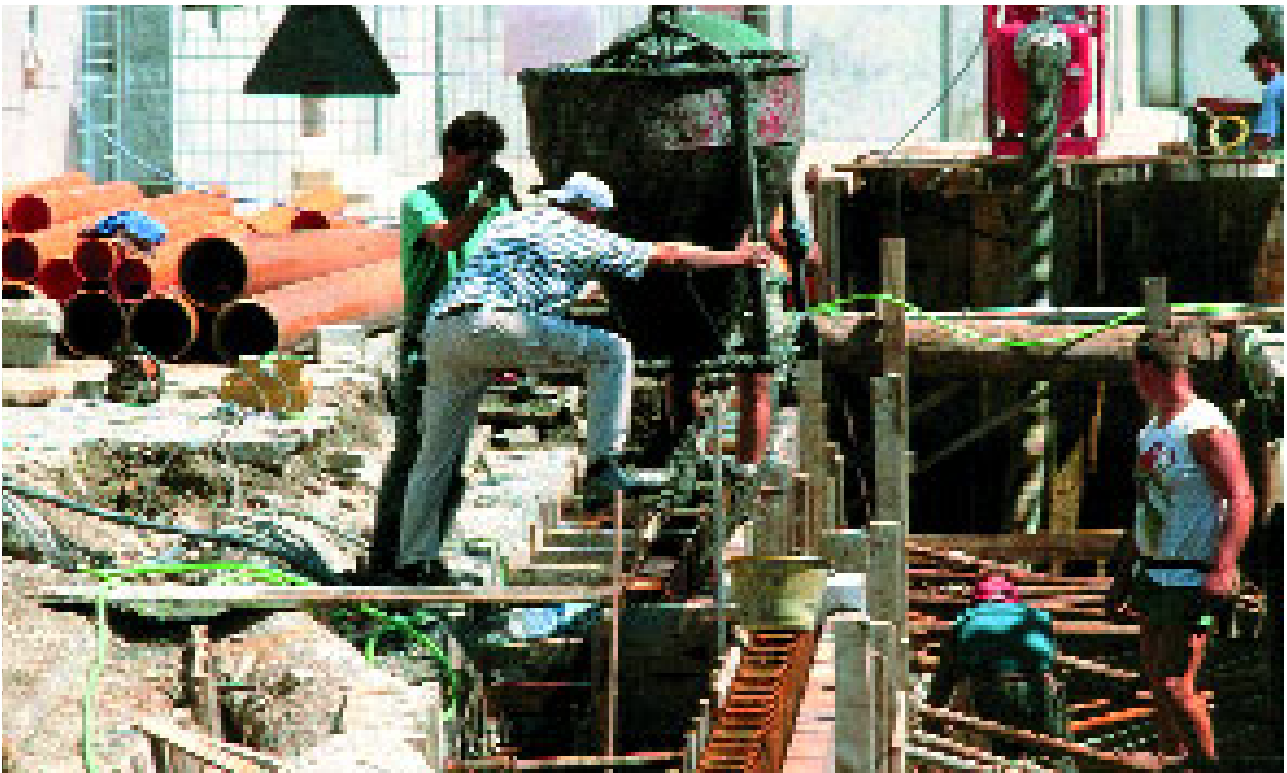
Fondamenta Venier, la realizzazione del nuovo muro di sponda
