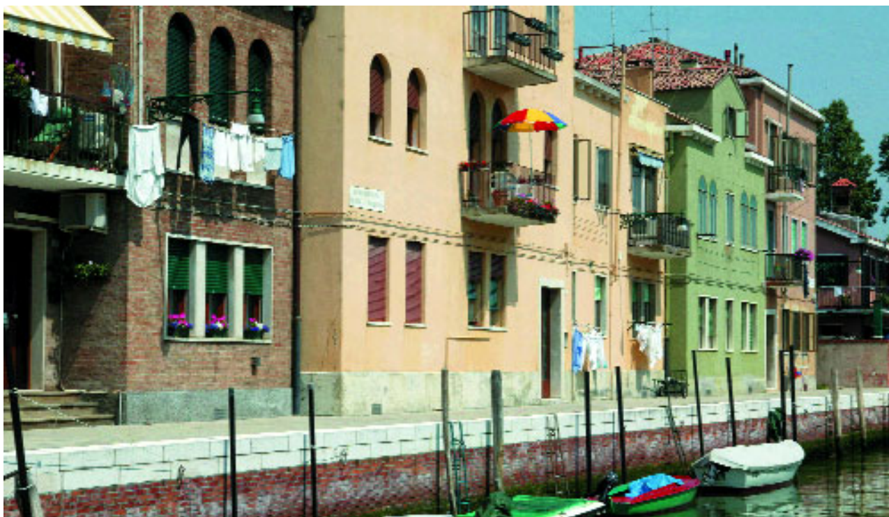
Fondamenta Tiepolo dopo i lavori di restauro
