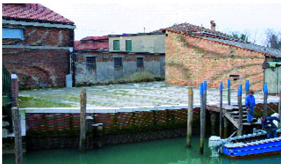
Fondamenta San Mattia dopo i lavori
