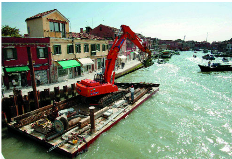
Il cantiere in fondamenta Cavour
