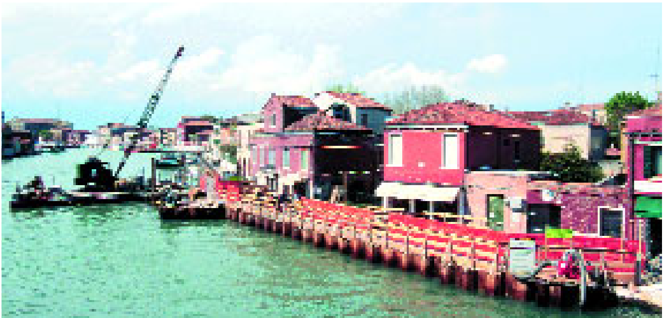
Fondamenta Venier durante i lavori
